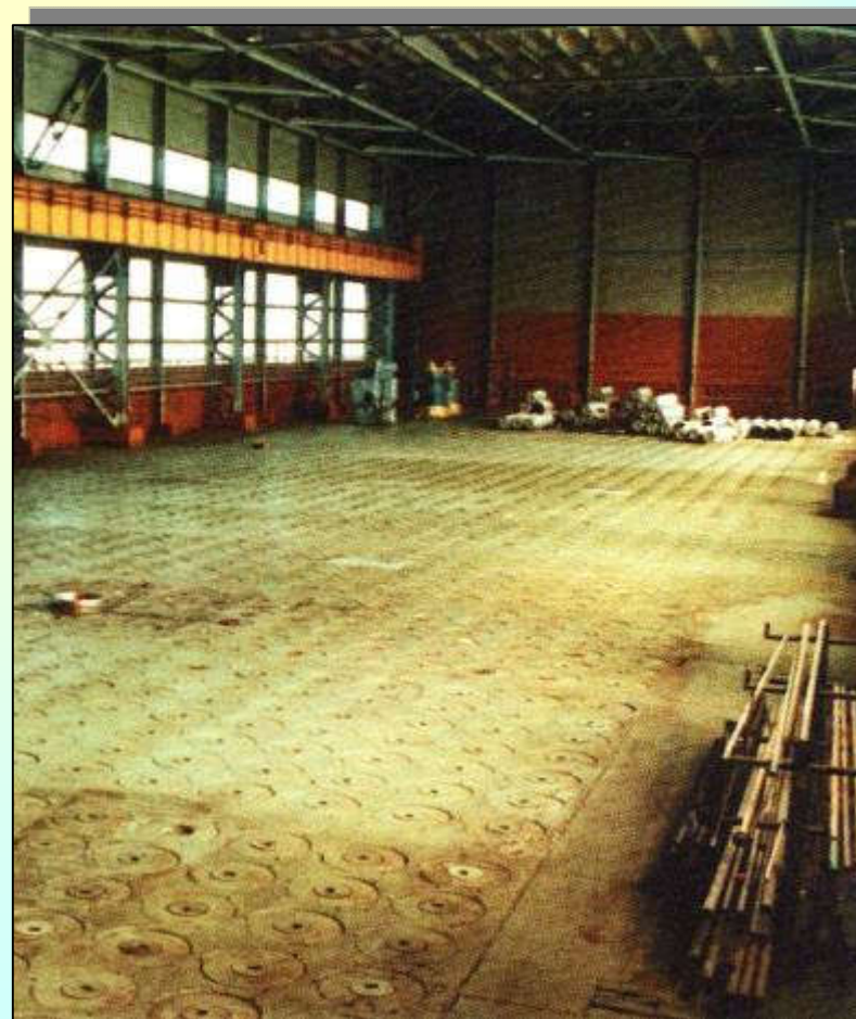
Хранилище остеклованных ВАО на ФГУП «ПО «Маяк»
